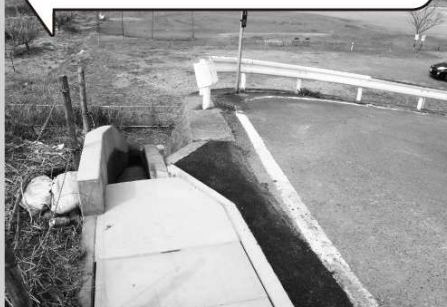
上豊岡運動広場入り口における雨水流入による土砂崩れ防止のため側溝を敷設。
