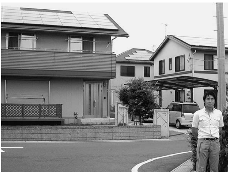
〈環境の現場〉 約600戸の家庭用ソーラーパネルが建ち並ぶ、パルタウン城西の杜（太田市）を先進地視察
